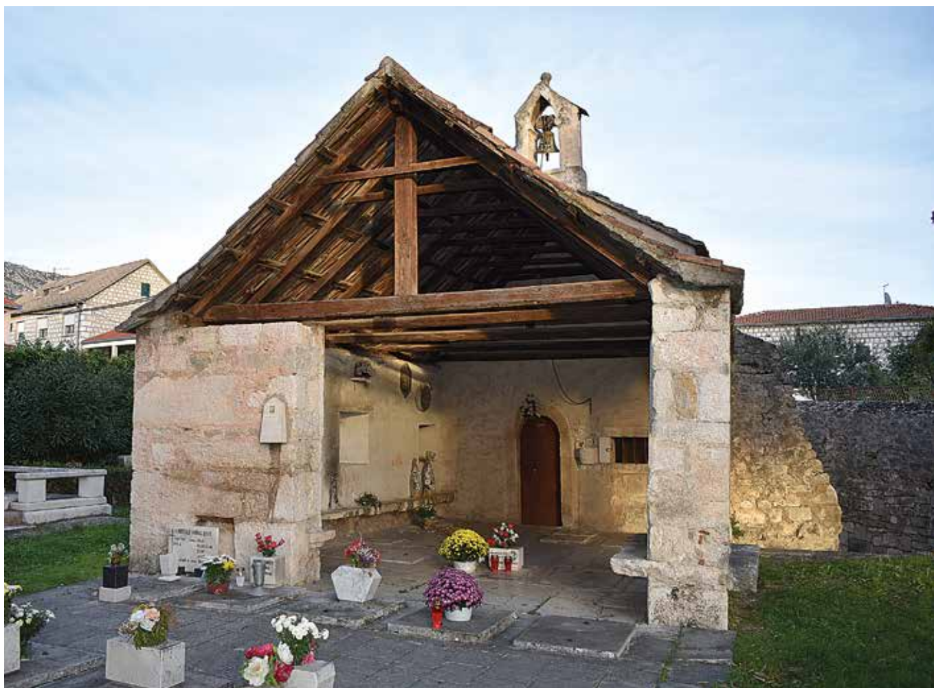
Slika 4. Pogled na Sv. Kuzmu i Damjana sa zapada; romanički portal i kontrafor gotičke zvonare na jugozapadnom uglu crkve (foto: D. Brajnov Botić)
