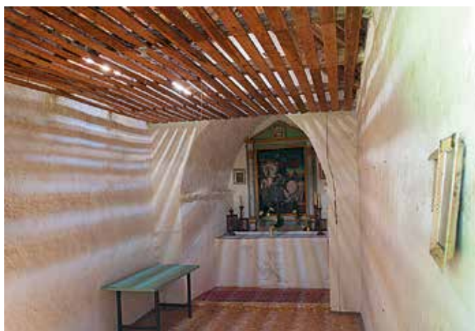
Slika 18. Unutrašnjost Sv. Jurja od Žestinja s gotičkim šiljastim lukom na ulazu u prezbiterij (foto: T. Bartulović)
